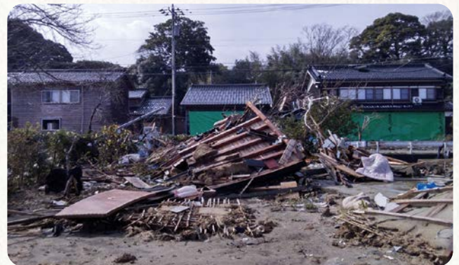
倒壊した家屋
